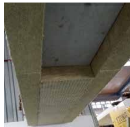
Sijas apakšējās virsmas uguns aizsardzība
